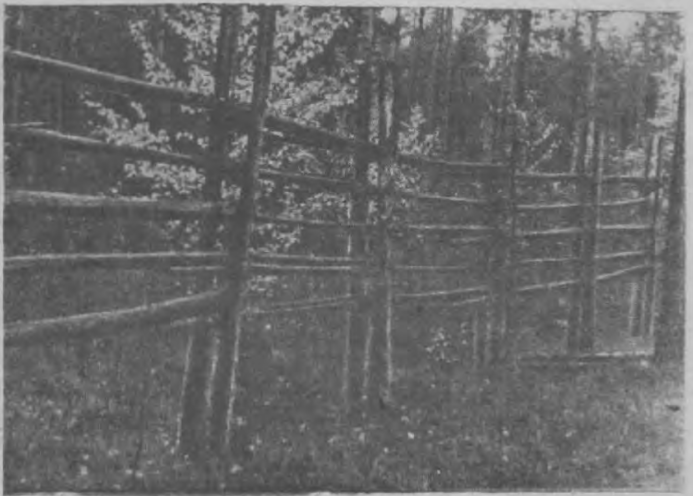
Рис. 1. Общий вид направляющей изгороди. Фото автора.
